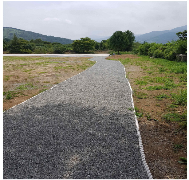
주차장 정비공사 완료
