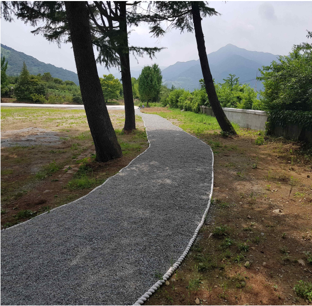
주차장 정비공사 완료
