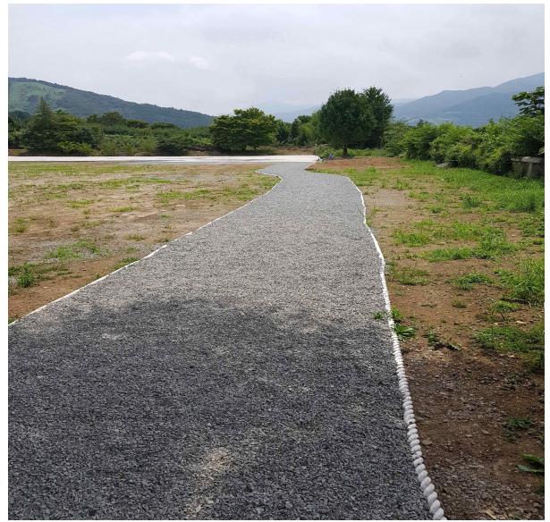
주차장 정비공사 완료
