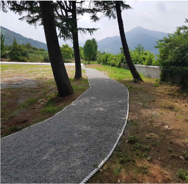
주차장 정비공사 완료
