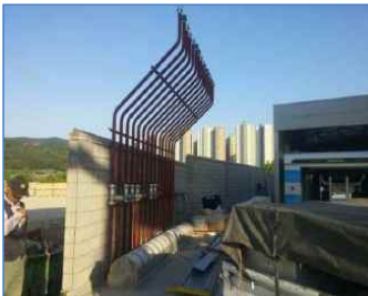
유증기 회수장치, 통기관 설치
