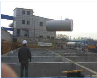
탱크조실 및 탱크 설치
