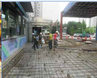
되메우기 및 바닥공사
