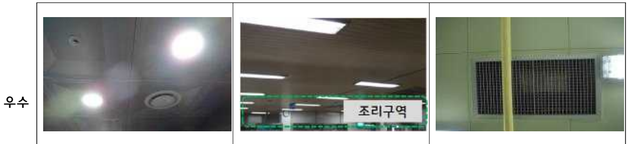
환풍장치 설치 및 정상작동
