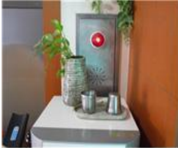
▲ 적재물로 인하여 소방시설 사용이 제한되는 경우
