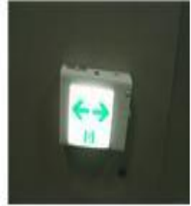
▲ 통로유도등이 올바르게 설치된 경우
