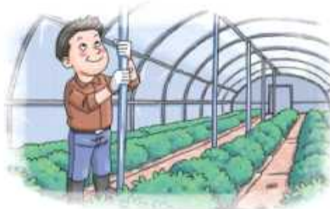
▲ 노후화된 시설 등은 보강지주 설치
